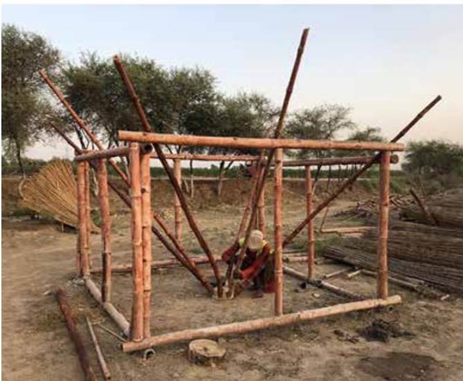
ช่างฝีมือหนุ่มกำลังฝึกฝนวิธีการสร้างหลังคาทรงกรวยให้บ้านแบบชอนรา (บ้านที่มีห้องเดียว) ในหมู่บ้านโพรียน ประเทศปากีสถาน
