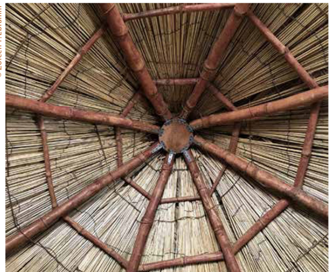
ด้านในหลังคาทรงแปดเหลี่ยมของบ้านแบบชอนรา ทำจากไม้ไผ่และมุงจาก
