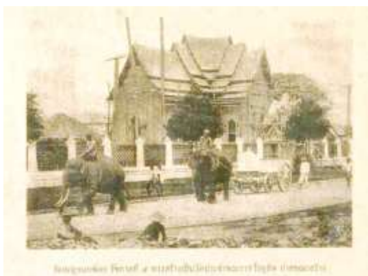
วัดเบญจมบพิตรขณะกำลังก่อสร้าง สมัย ร.๕ มีการใช้ช้างลากวัสดุก่อสร้าง
